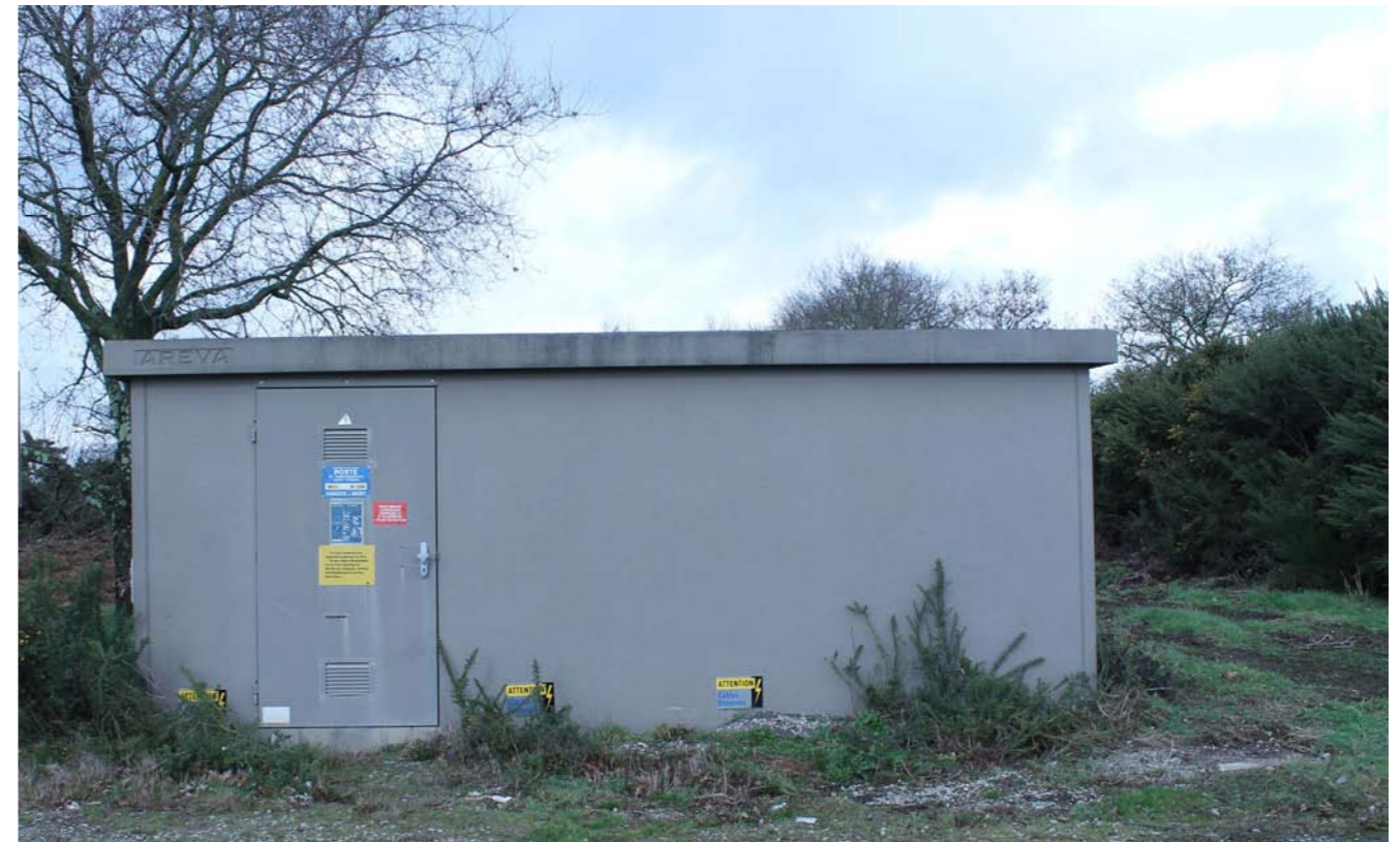
Photo 1 : Poste de livraison du parc de Derval-Lusanger à Derval
